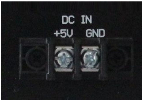
Рисунок 16 – Ввод 5В DC (устройство UniPing server solution v3/SMS)
