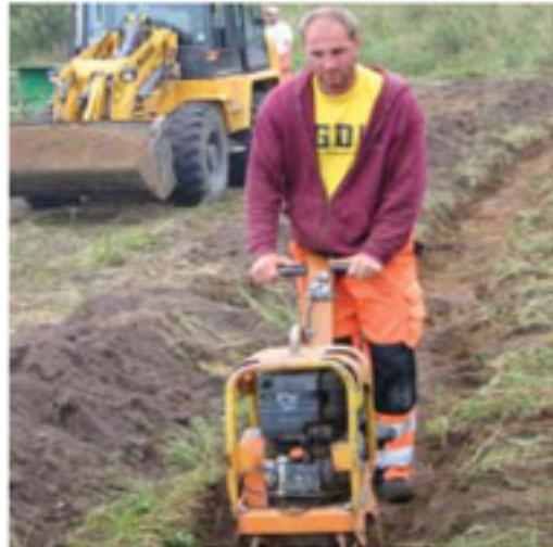
После выполнения засыпки (на 50-75 см), грунт следует утрамбовать, чтобы укрепить траншею для кабельного канала.
