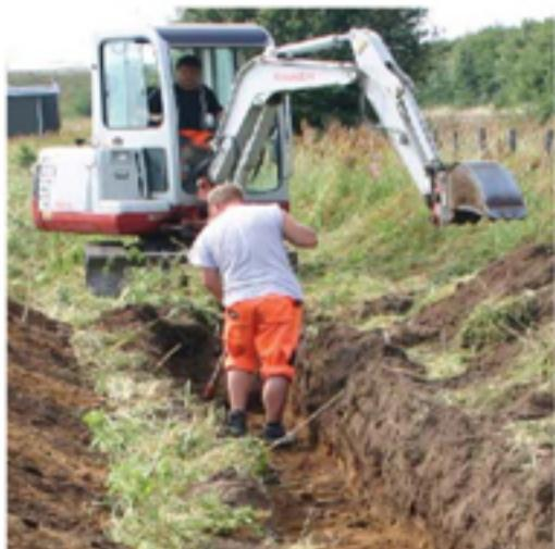
Следует выкопать плоское и ровное дно траншеи для кабельного канала. Во избежание впадин и тому подобных дефектов на мягких грунтах, дно траншеи для кабельного канала должно быть полностью стабильным и твердым.
