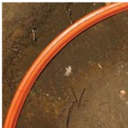
При укладке изгибов следует установить канал FLATLINER в вертикальной позиции.
