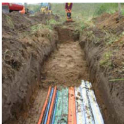
При засыпке траншеи грунтом, постоянно натягиваете каналы, чтобы обеспечить отсутствие помех при пневматической прокладке.
