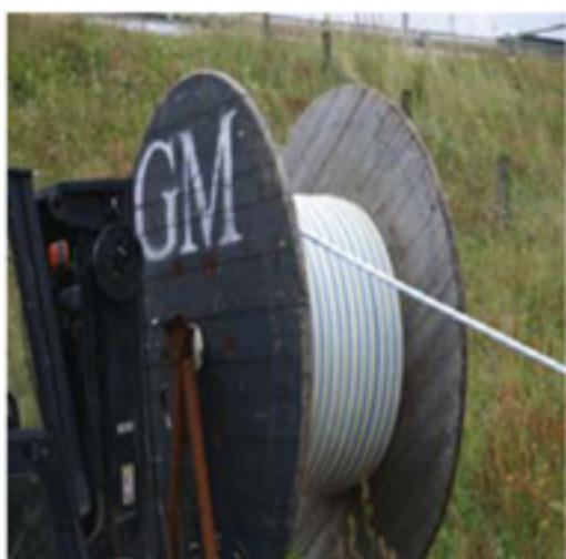
Во время отмотки труб очень важно, чтобы трубы отматывались сверху барабана, а не снизу. Это предохранит трубу от самостоятельного загиба сверху и поможет в выпрямлении труб. Во избежание тягового повреждения трубы, рекомендуется разматывать ее сразу в траншее.
