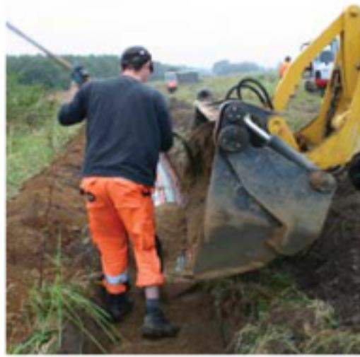
Засыпку следует произвести вручную. Слишком интенсивная механическая засыпка может привести к неудачному давлению на трубу, которое может привести к дополнительному сопротивлению при пневматической прокладке.
