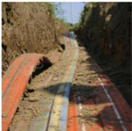
Трубу следует натянуть в траншее для кабельного канала. Солнце и тепло вызовут удлинение пластикового материала, и труба начнет вытягиваться, что усложнит пневматическую прокладку.
