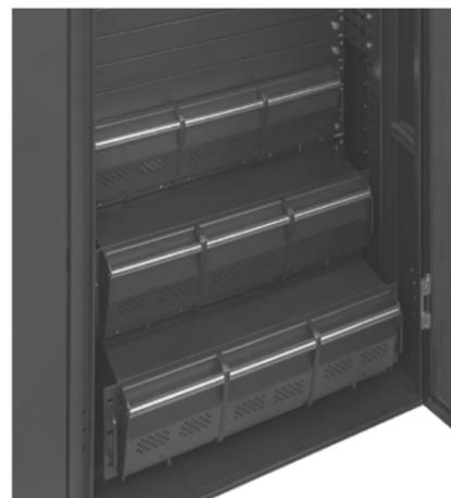
В комплекте с ИБП, можно приобрести батарейные модули. Для одного силового модуля 10 кВА аккумуляторный модуль сможет обеспечить 9 минут автономной работы. Для ИПБ необходимо не менее двух батарейных модулей, разместить которые можно в свободное пространство ИБП.
